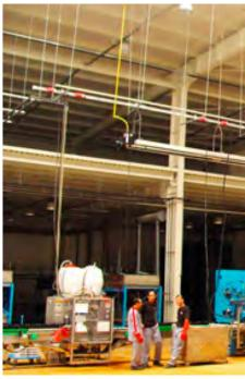
I tubi radianti irraggiano direttamente le superfici e le persone offrendo un perfetto comfort termico anche in edifici di grande volumetria. Sono equipaggiati con tubi emettitori calorizzati, questo permette di non utilizzare vernici che con il tempo potrebbero staccarsi dal tubo.
