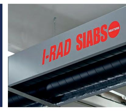
Riscaldatori ad irraggiamento con possibilità di installare il bruciatore e la linea gas esternamente all'edificio, evitando così di dover fare fori nel tetto per i camini. La manutenzione ordinaria viene, in questo modo, effettuata all'esterno dell'edificio, senza dover interrompere l'attività dell'azienda.
